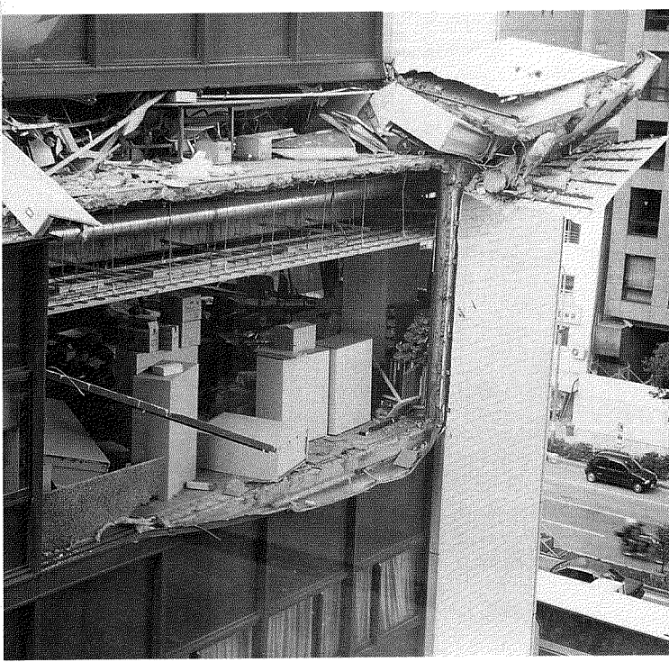
神戸市役所2号館 1957年完成、8階建て。5階までは鉄骨コンクリート。中間破壊した6階と7、8階は鉄筋コンクリート（神戸市中央区、1月30日撮影）
